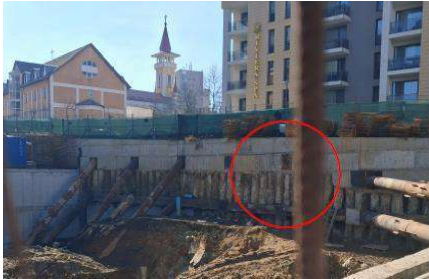
Figura 5. Consolidarea elemente de sus
