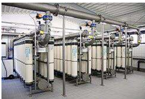
Figura 3. Tratarea apei potabile 300m 3 /h prin ultrafiltrare [13].
