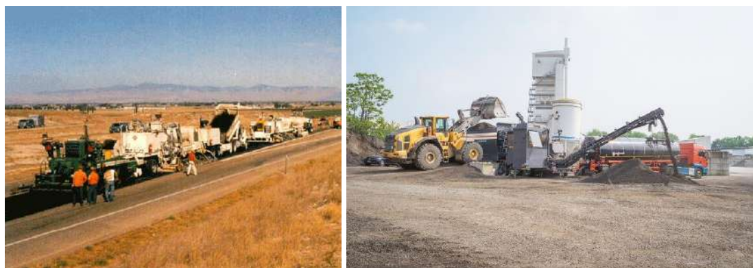
Figura 4. Execuție pe șantier (în situ) (stânga) și execuție în stație de asfalt (dreapta)
