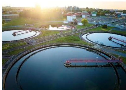
Figura 5. Stație de epurare a apelor [21].
