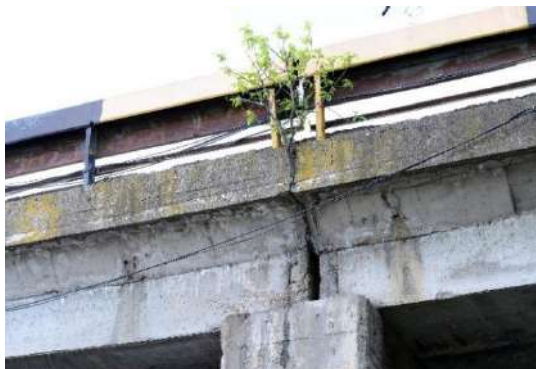
Figura 1. Prezența vegetației pe elementele infrastructurii
