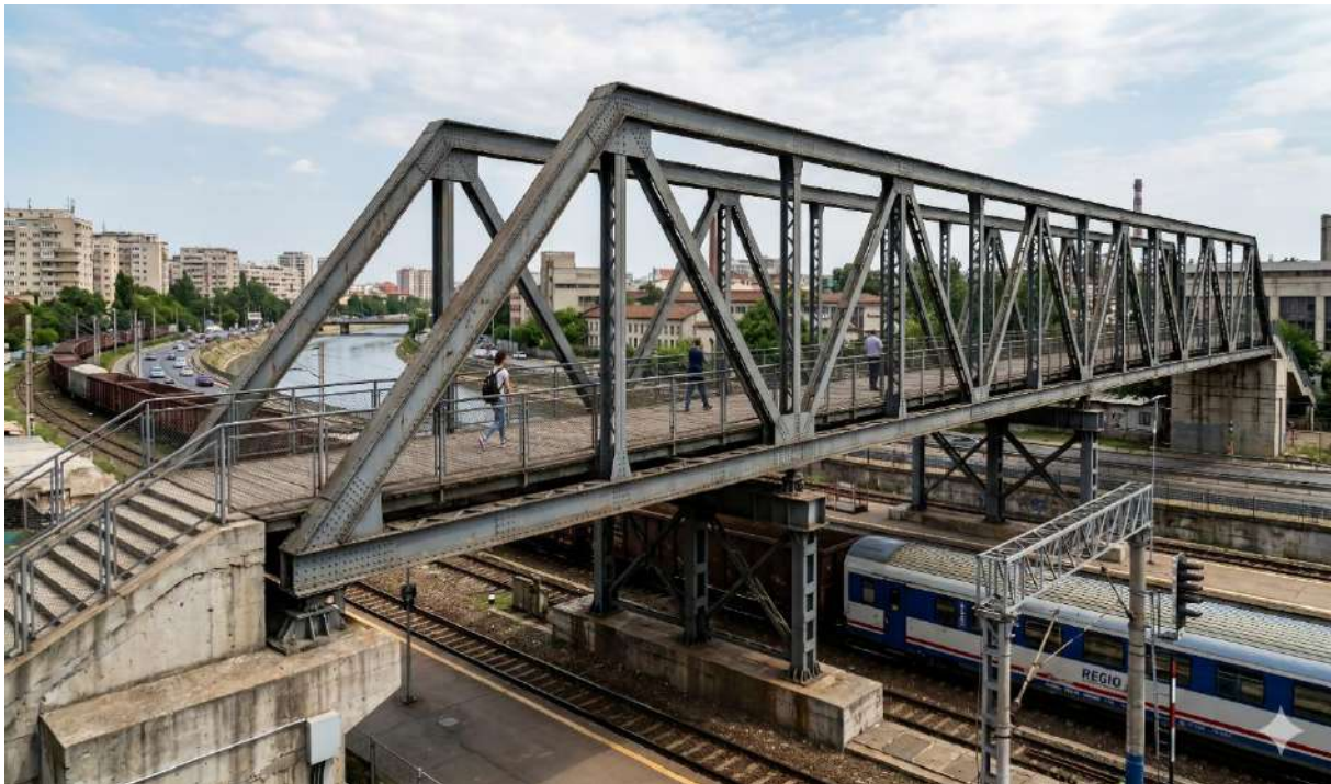
Figura 1. Pasarela pe grinzi cu zăbrele
