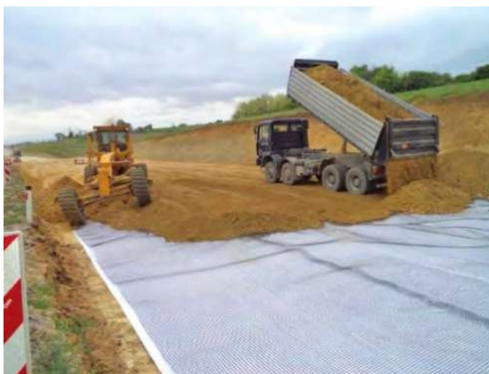
Figura 6. Punere în operă geocompozit.
