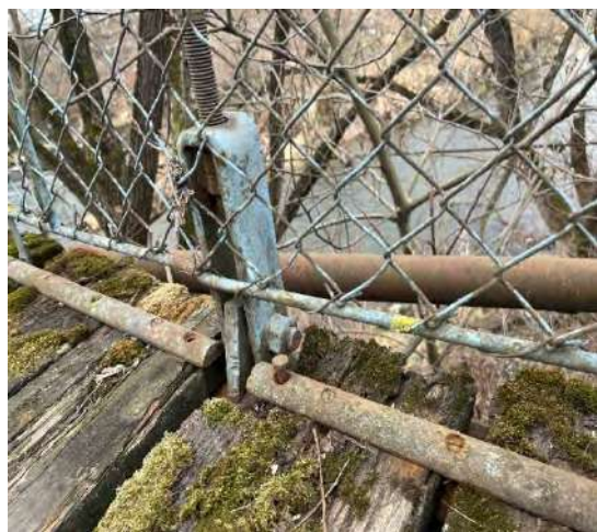
Figura 8. Prinderea elementelor metalice slăbite
