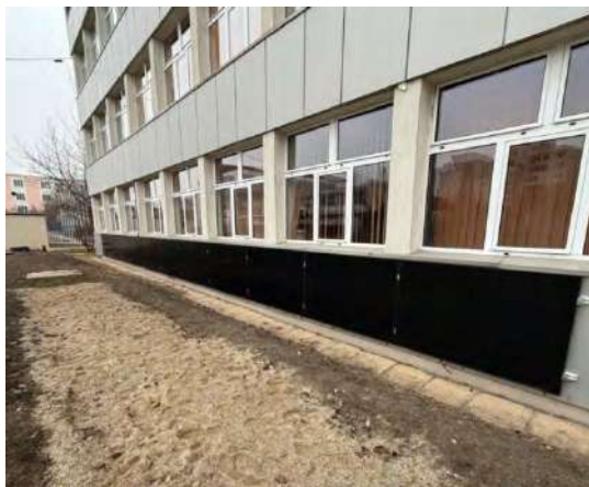
Figura 1. Reprezentarea sistemului de panouri fotovoltaice.
