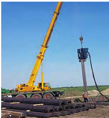
Figura 8. Macara ce introduce palplanșe.
