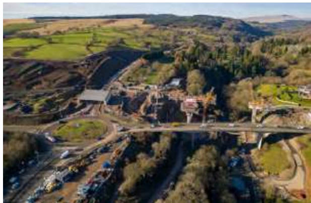
Figura 6. A465 Heads of the Valleys – în proiect sunt incluse panouri de beton autovindecabil
