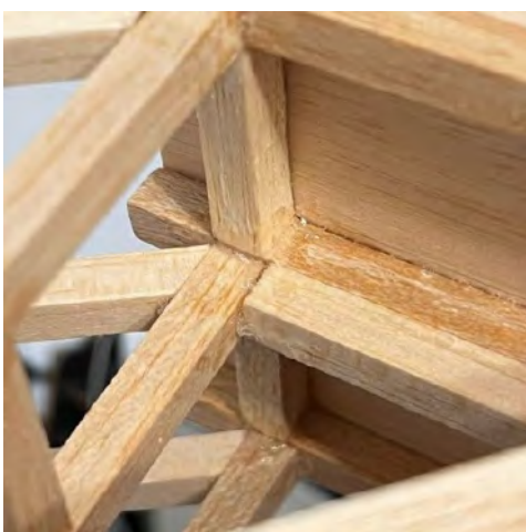
Figura 5. Detaliu îmbinare travee și montan.
