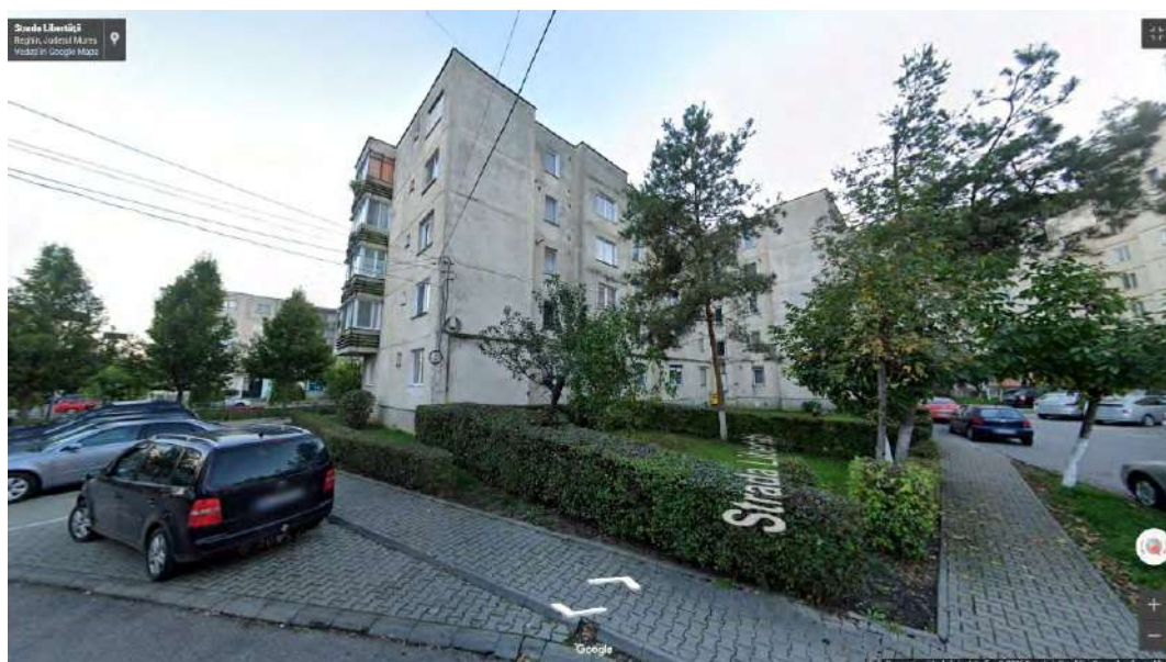
Figura 4. Punctul de prelevare a probei de apă -rețea de distribuție Reghin
