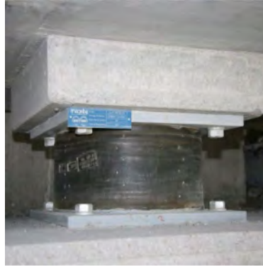
Figura 2. Izolator seismic. prosistem.ro
