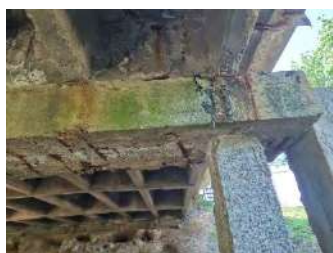
Figura 4. Vedere de jos platelaj
