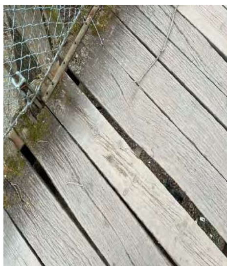
Figura 11. Uzura căii pe pod
