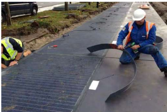
Figura 5. SolaRoad – Tehnologia de execuție.
