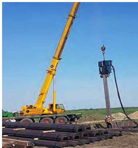
Figura 8. Macara ce introduce palplanșe.
