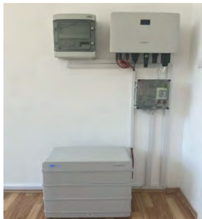
Figura 2. Reprezentarea invertorului și bateriei de stocare
